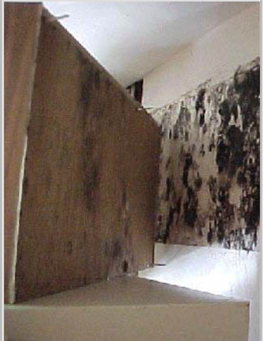
Figuur 2: Schimmelgroei op de muren
